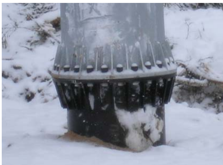
Рис. Б.16 -Фундамент из стальной сваи-оболочки.
