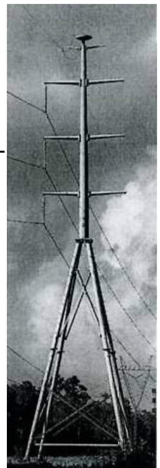
Рис. А.25 - Опора с комбинированной стойкой.
