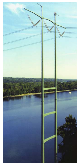
Рис. А.14 - Переходная опора ВЛ 500 кВ через водоём
